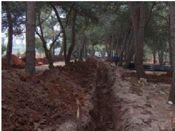
Jarek za kanalizacijo po sredini Ljubljanske ceste
